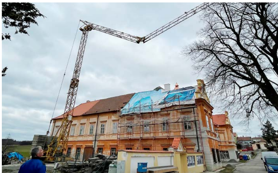
Instalace stavebního jeřábu Potain na jihozápadním křídle k pracem na poslední části střechy zámku. Foto: Josef Daněk
