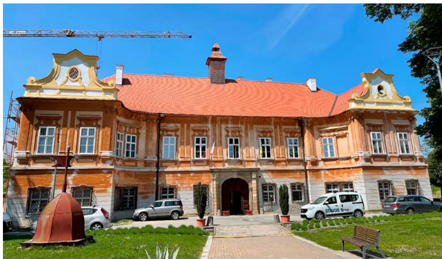
Dokončená střecha v průčelí zámku s věží. Práce se protáhly, protože byla uplatněna reklamace na kvalitu prací. Část střechy musela být rozebrána a pořádně přeložena. Foto: Josef Daněk
