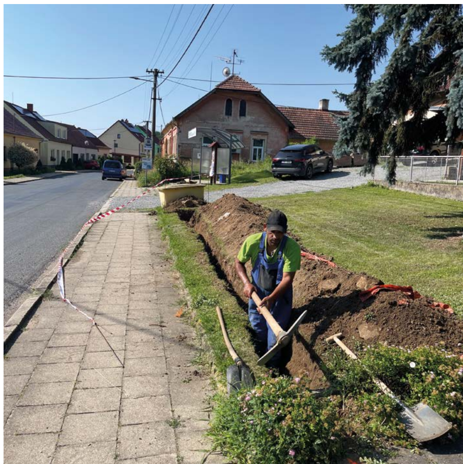
Výkopy pro položení optických kabelů probíhají po trase metalického vedení telefonních linek kladených v počátku devadesátých let minulého století. Foto: Josef Daněk
