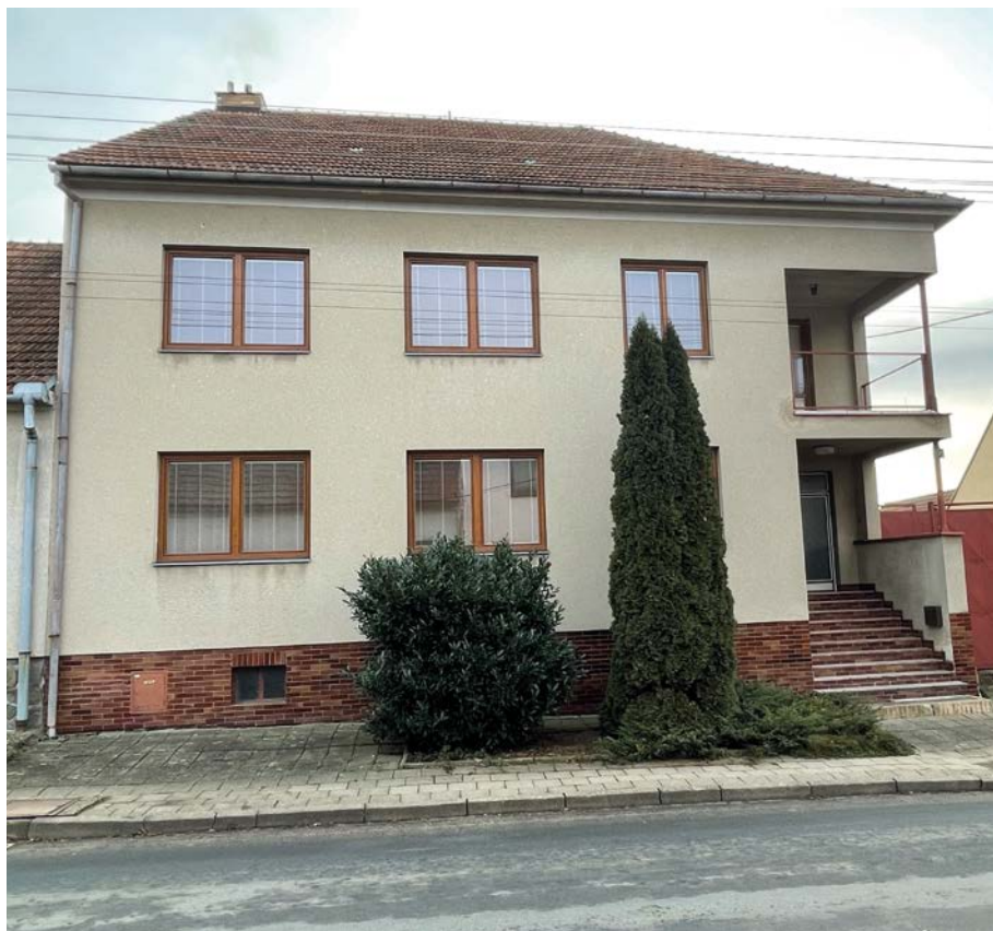
Dům č.p. 82 ve vlastnictví obce Prštice na Ulici Hlavní
